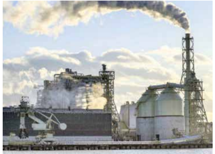
▲ Một nhà máy nhiệt điện than ở Nhật Bản được xây dựng trước năm 1995 có hiệu suất thấp và phát thải nhiều khí CO 2
