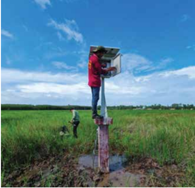
▲ Lắp đặt trạm quan trắc chất lượng không khí tại VQG Tràm Chim
