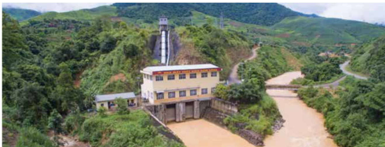
▲ Dự án công trình thủy điện Nậm Công 4 (Sơn La)
