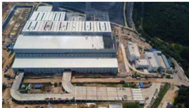
▲ Nhà máy Điện rác Thiên Lý, Sóc Sơn, Hà Nội, vốn đầu tư khoảng 7.000 tỷ đồng, công suất đốt rác 5.000 tấn rác ướt mỗi ngày, công suất phát điện 75 MW
