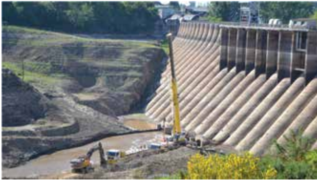
▲ Phá dỡ đập Vézins cao 36m trên sông Sélune (Pháp)
