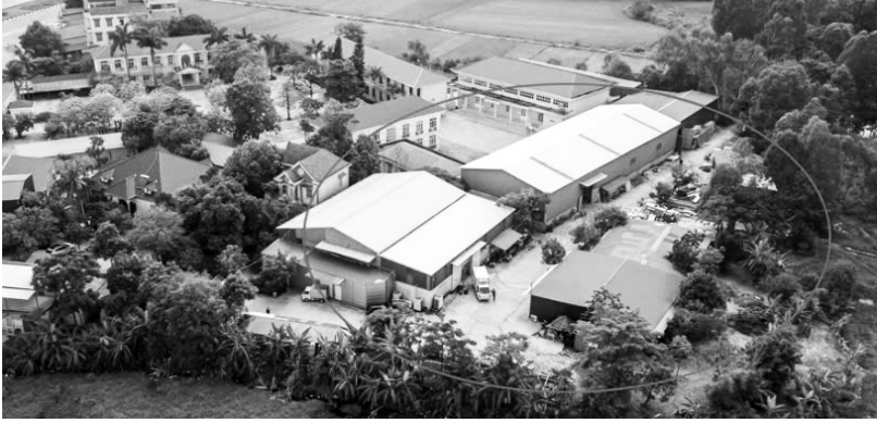
Hoạt động xây dựng xưởng trái phép trên đất nông nghiệp tại địa bàn xã Thiện Kế, huyện Bình Xuyên
