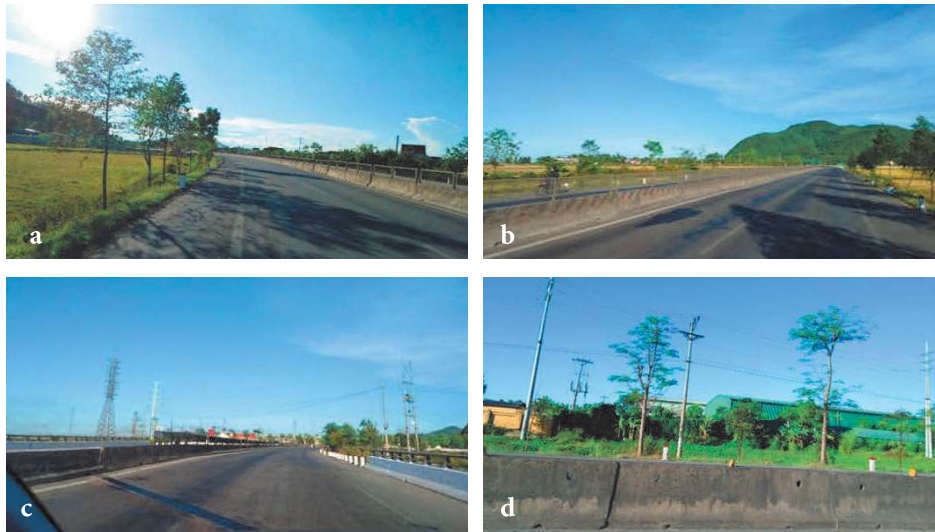
Hình 1. Một số hình ảnh về hiện trạng kết cấu hạ tầng tuyến đang khai thác tuyến quốc lộ đoạn TP Vinh – TX. Hồng Lĩnh a. Mặt cắt đường và hàng lang cây xanh b. Toàn cảnh một đoạn đường c. Kết cấu đường đoạn qua cầu không có cây xanh d. Dải phân cách giữa bê tông không cây xanh
