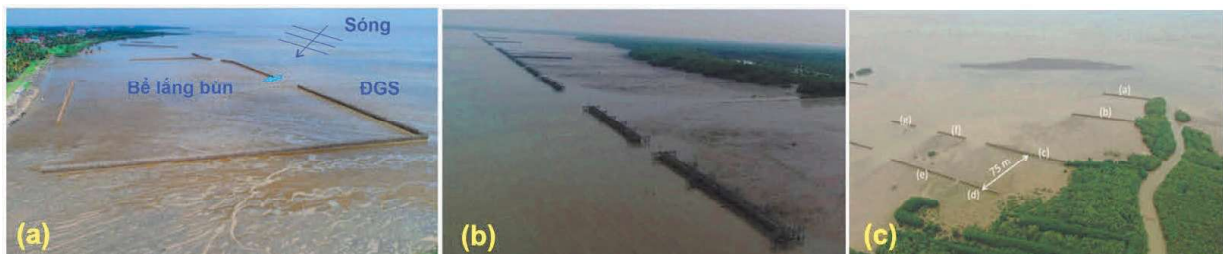
Hình 5. Bố trí không gian công trình để gây bồi (a) Khi bãi nông (b) Khi bãi sâu (c) Bãi rộng: Chia làm nhiều lớp/đợt công trình gây bồi
