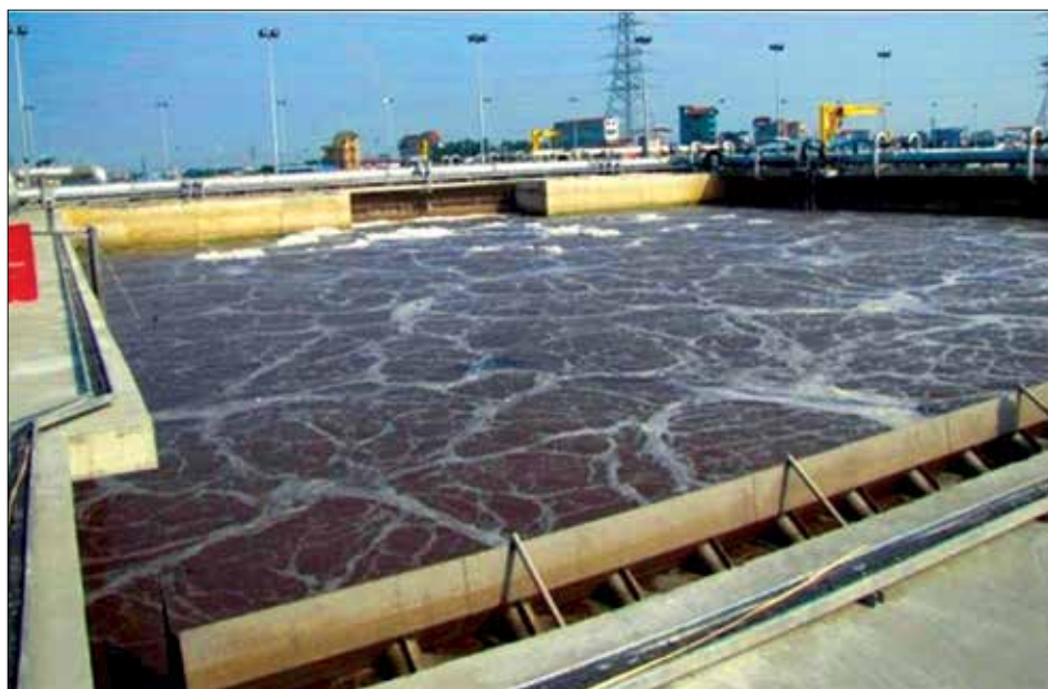
▲ Nhà máy XLNT Yên Sở (Hà Nội) được đầu tư theo hình thức BT, có công suất 200 nghìn m 3 /ngày, đêm
