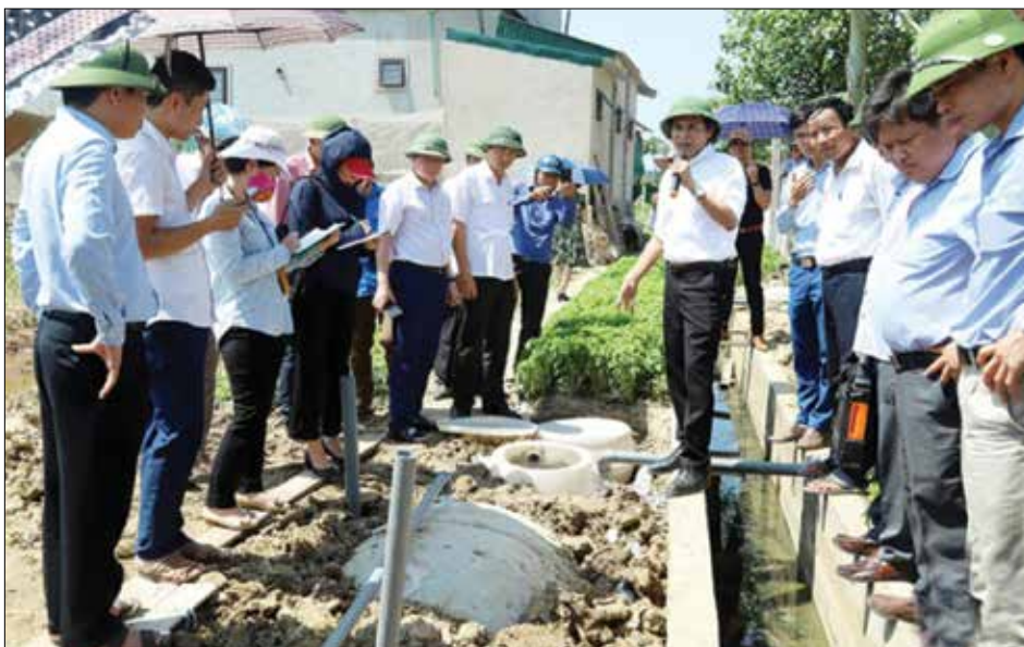
▲ Tham quan mô hình xử lý nước thải trong khu dân cư, góp phần xây dựng NTM tại Hà Tĩnh
