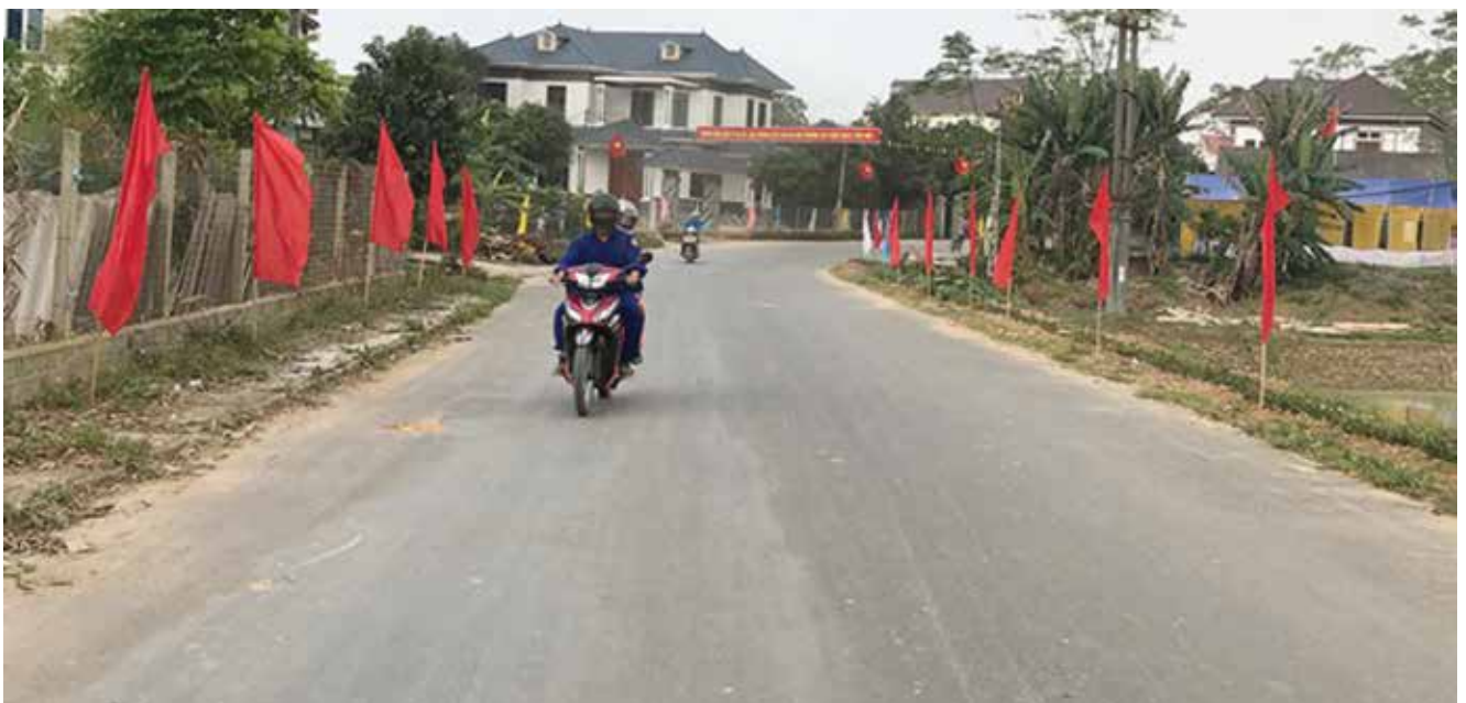
▲ Nhiều tuyến đường trên địa bàn tỉnh được bê tông hóa
