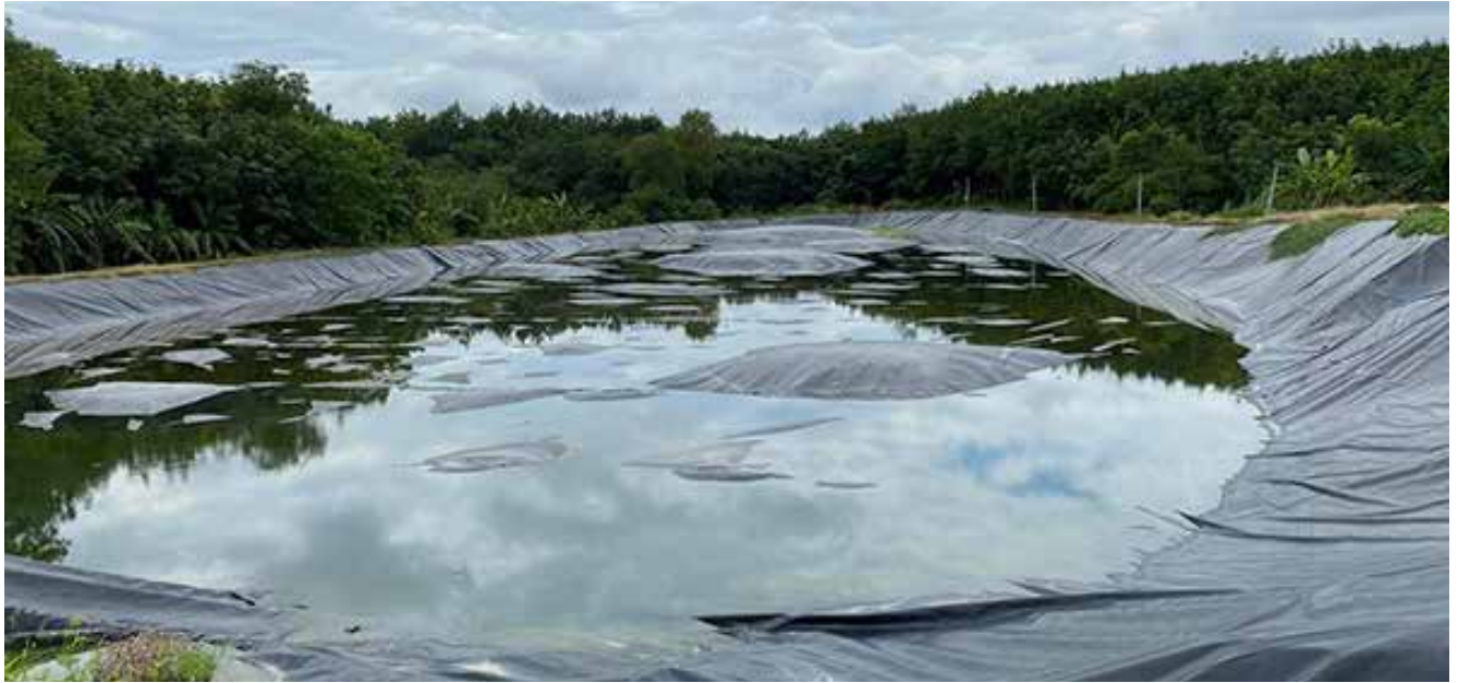
▲ Hồ thu gom nước thải từ Nhà máy chế biến cao su
