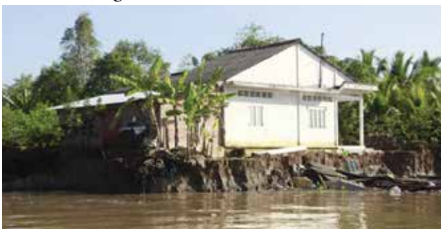
▲ Hình 7c. Nguy cơ sạt lở tại khu vực bờ sông Cổ Chiên tỉnh Vĩnh Long
