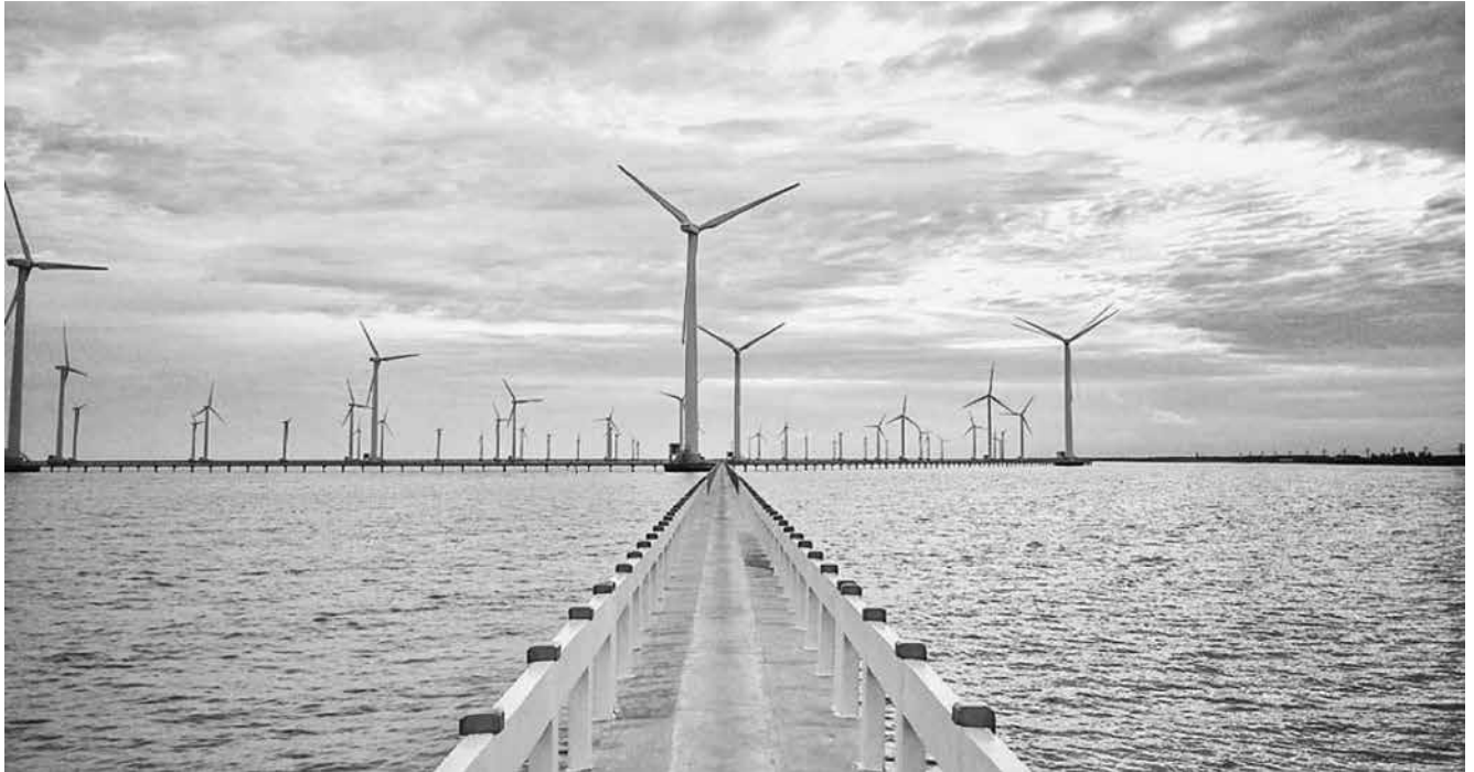
▲ Nhà máy điện gió Bạc Liêu
