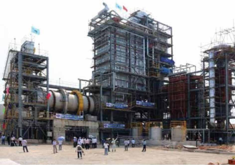
▲ Nhà máy điện rác Seraphin đặt tại Khu xử lý CTR Xuân Sơn, Sơn Tây
