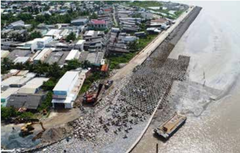
▲ Kè chống sạt lở thích ứng với BĐKH tại tỉnh Bạc Liêu
