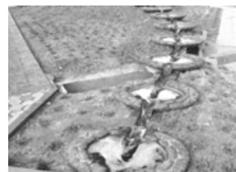
Máng tràn bậc thang tạo sóng, tăng ô xy cho nước và tạo cảnh
