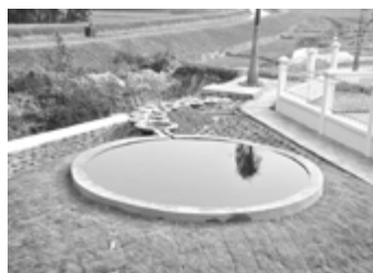
Bể phân phối nước sau bể kỵ khí ngầm
