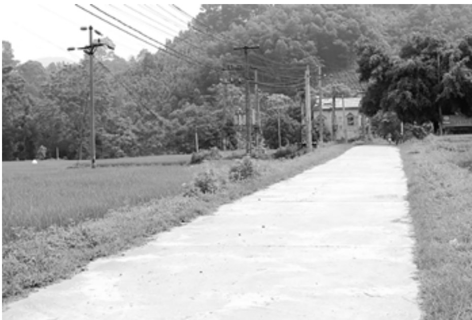
▲ Hệ thống điện, đường giao thông nông thôn ở xã Hòa Cường, huyện Trấn Yên được nâng cấp, đáp ứng nhu cầu đời sống kinh tế - xã hội của nhân dân
