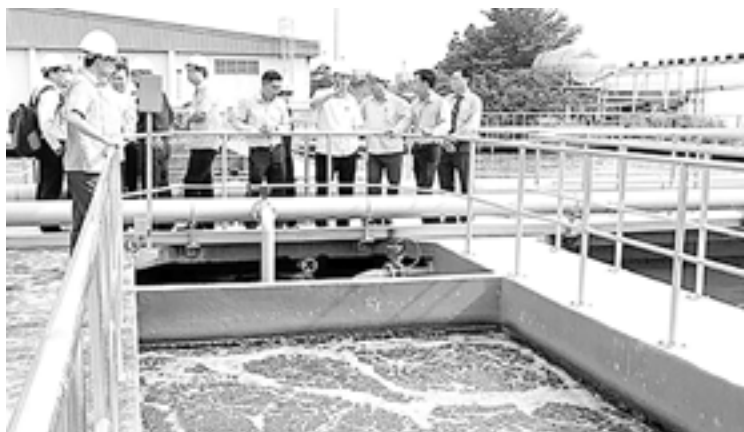
▲ Nhà máy XLNTTT tại KCN Nhơn Trạch 2
