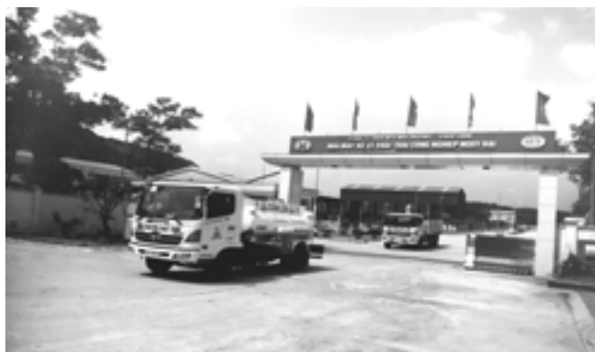
▲ Nhà máy xử lý CTNH công nghiệp của TKV
