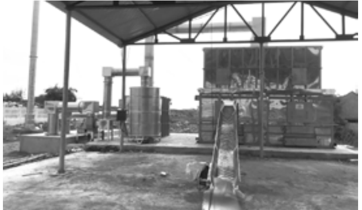
▲ Lò đốt LOSIHO - xử lý rác thải sinh hoạt hiệu quả, góp phần cải thiện môi trường nông thôn
