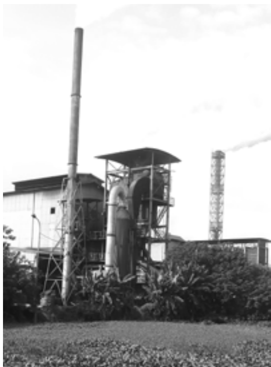
▲ Nhà máy xử lý rác thải sinh hoạt của Công ty CP Môi trường và Công trình đô thị Thái Bình
