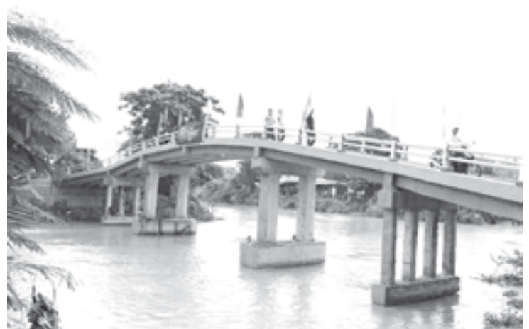
▲ Cây cầu kênh Hòa Bình tại xã Phú Thành (Phú Tân, An Giang) được làm từ nguyên liệu tái chế
