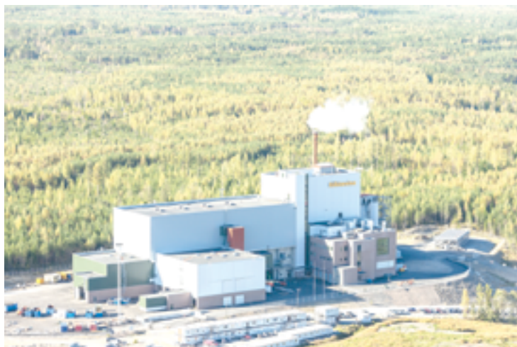
▲ Nhà máy xử lý chất thải thành năng lượng (WtE) Riikinvuori Ekovoimalaitos tại thị trấn Varkaus (Phần Lan)
