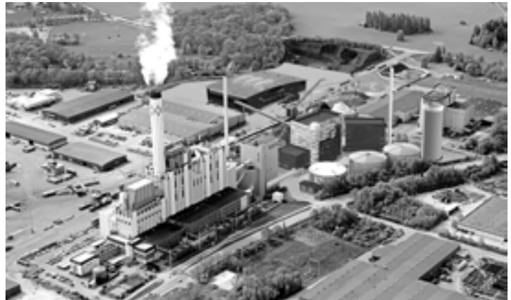
▲ Nhà máy đốt rác thu hồi năng lượng Vasteras (Thụy Điển)
