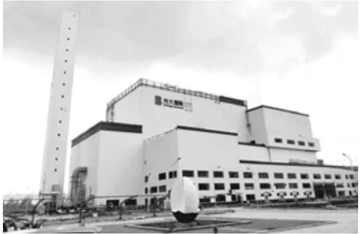
▲ Nhà máy đốt rác phát điện Cần Thơ
