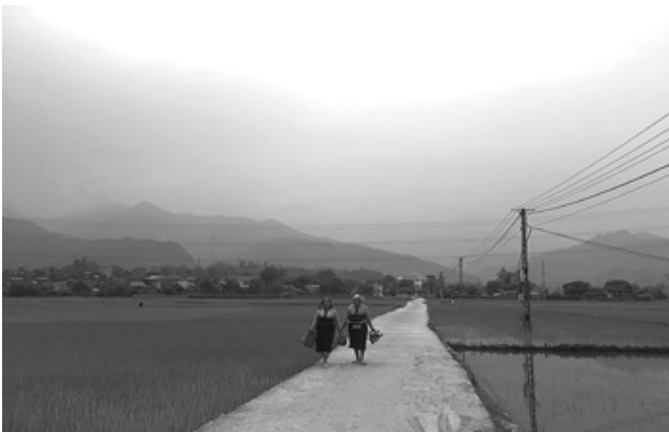
▲ Đường làng ngõ xóm tại xã Huy Hạ được bê tông hóa
