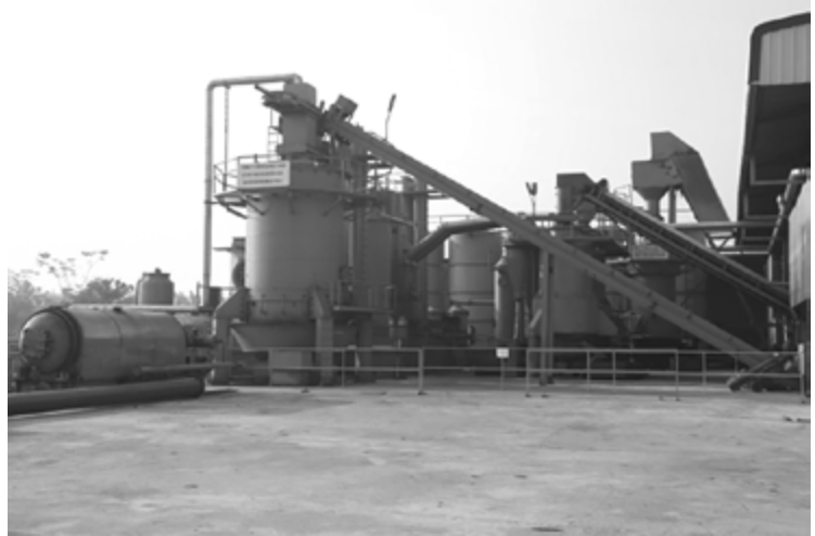
▲ Lò khí hóa đa nhiên liệu của Nhà máy xử lý rác công nghệ cao tại Hưng Yên
