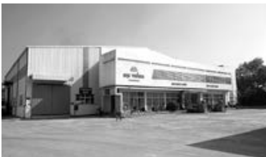
▲ Nhà máy xử lý rác thải của Công ty Đại Thắng tại KCN Nam Cầu Kiền
