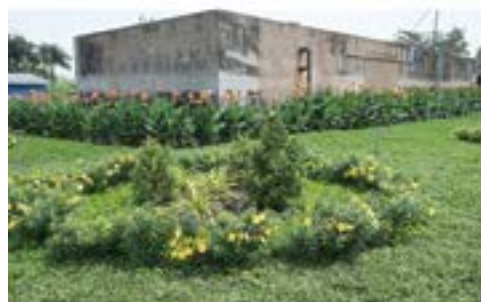
Tiểu cảnh cây xanh xung quanh khu xử lý nước thải của nhà máy
