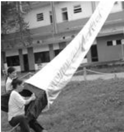
▲ Hình 4. Lắp đặt ống tuột nghiêng ON30
