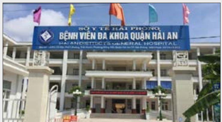
▲ Bệnh viện Đa khoa quận Hải An là một trong 5 bệnh viện được đầu tư hệ thống xử lý nước thải y tế giai đoạn 2019 - 2020
