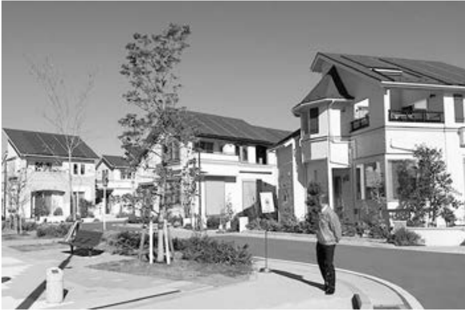
▲ Các tấm pin mặt trời được lắp đặt trên mỗi mái nhà của TP. Fujisawa
