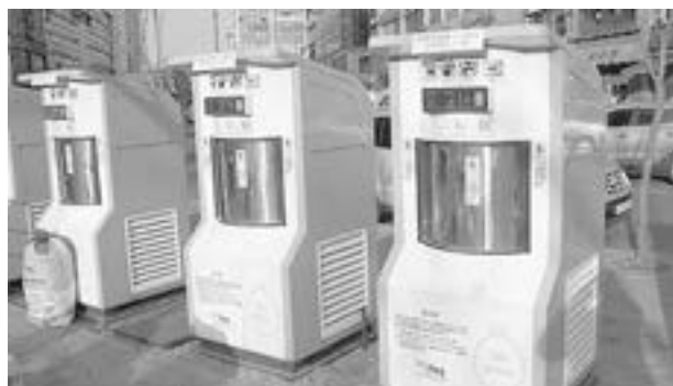
▲ Thùng rác kết nối với ống khí nén vận chuyển bên dưới ở TP. Songdo, Hàn Quốc
