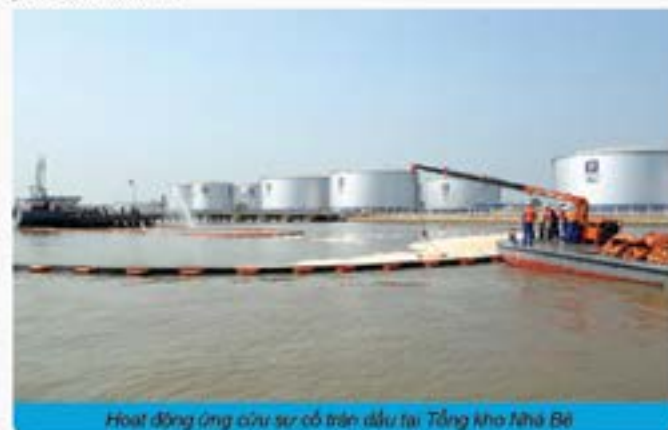
Hoạt động ứng cứu sự cố tràn dầu tại Tổng kho Nhà Bè
