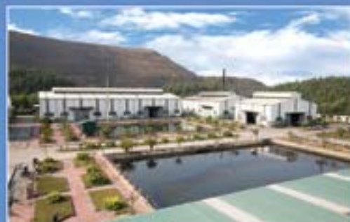
Nhà máy Xử lý chất thải nguy hại
