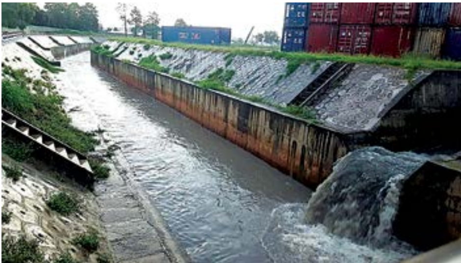
▲ Kênh Ba Bò (đoạn chảy qua tỉnh Bình Dương) đã được cải tạo và xây dựng bờ kè
