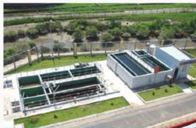
Hệ thống xử lý nước thải tập trung được đầu tư hiện đại
