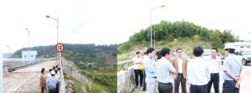
Cục Kỹ thuật an toàn và Môi trường Công nghiệp - Bộ Công thương kiểm tra công tác vận hành hồ chứa
