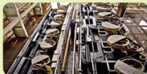
▲ Bể lắng bùn thải Nhà máy tuyển quặng
