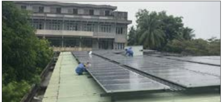
▲ Công nhân SolarBK lắp đặt hệ thống pin NLMT trên nóc tòa nhà ĐH Bách khoa Đà Nẵng
