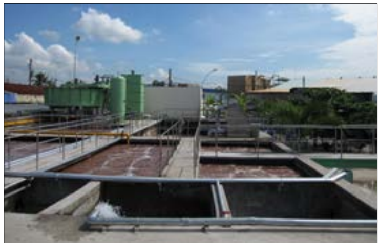
▲ Hệ thống xử lý nước thải của Công ty Agifish An Giang
