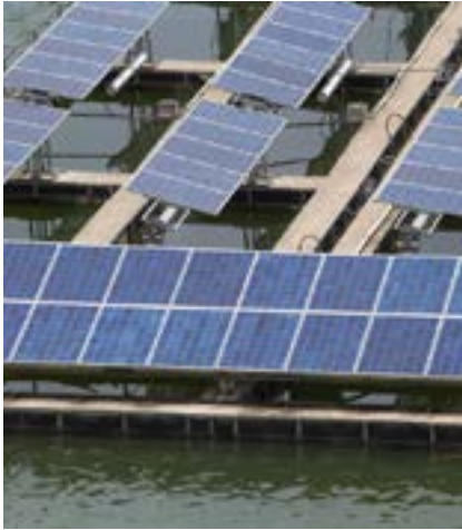
▲ Xây dựng hệ thống đèn năng lượng mặt trời tại các đường thủy nội địa
