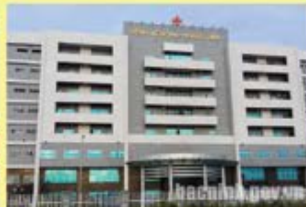
▲ Bệnh viện Sản - Nhi tỉnh Bắc Ninh
