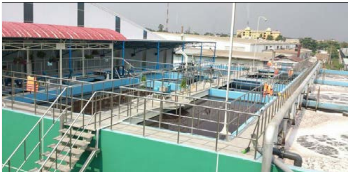
▲ Trạm xử lý nước thải dệt nhuộm của Công ty TNHH Chyang Sheng Việt Nam (thị xã Thuận An - Bình Dương)
