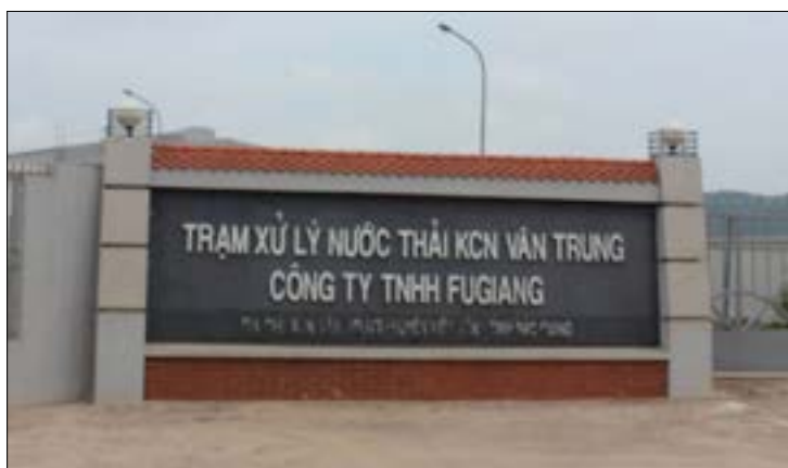
▲ KCN Vân Trung là một trong 4 KCN trên địa bàn tỉnh Bắc Giang có trạm xử lý nước thải tập trung
