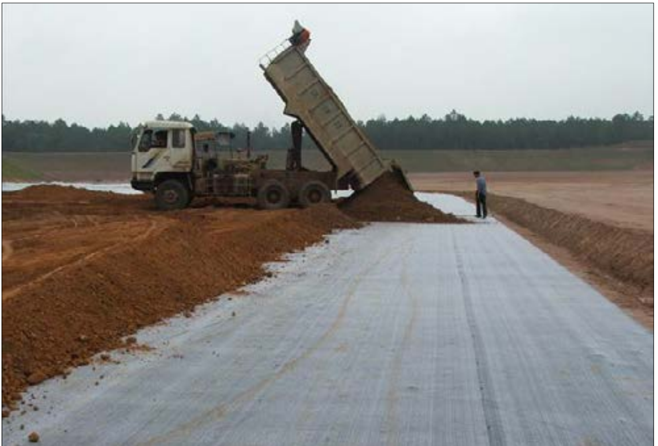
▲ Các tấm vải địa kỹ thuật được sử dụng để phục hồi, gia cố nền đường tại các khu vực đất yếu như đầm phá, đê, đập, kênh mương thủy lợi, kè sông
