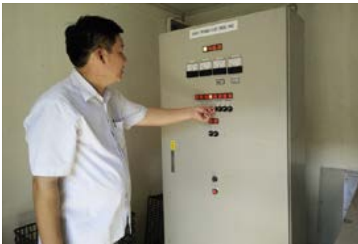
▲ Hệ thống xử lý nước thải tại Bệnh viện Đa khoa tỉnh Sơn La có công suất thiết kế 350 m 3 /ngày đêm.
