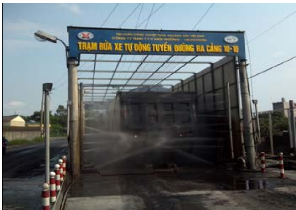
▲ Trạm rửa xe ô tô tuyến đường mở Cọc Sáu - TP. Cẩm Phả, Quảng Ninh
