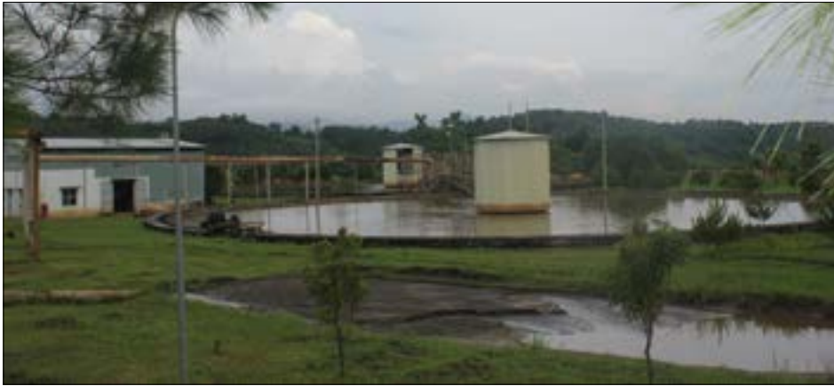
▲ Bể lắng bùn thải Nhà máy tuyển quặng
