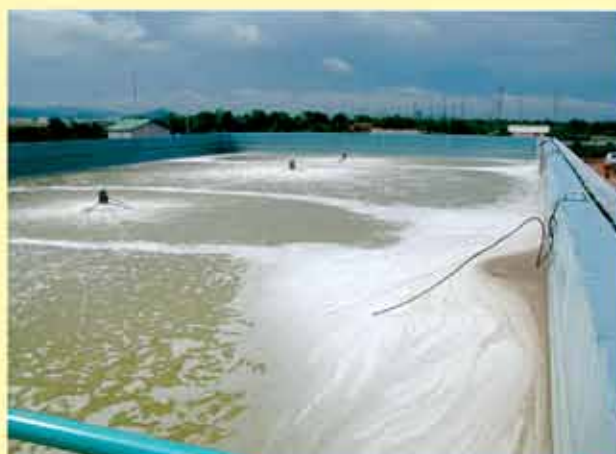
Nhà máy xử lý nước thải tập trung KCN
