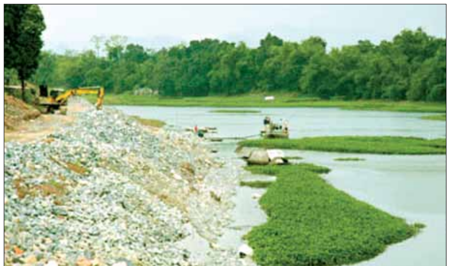
▲ Tỉnh Hà Nam đang cải tạo gia cố bờ sông Đáy đoạn qua TP. Phủ Lý nhằm tạo cảnh quan môi trường Xanh - Sạch - Đẹp
