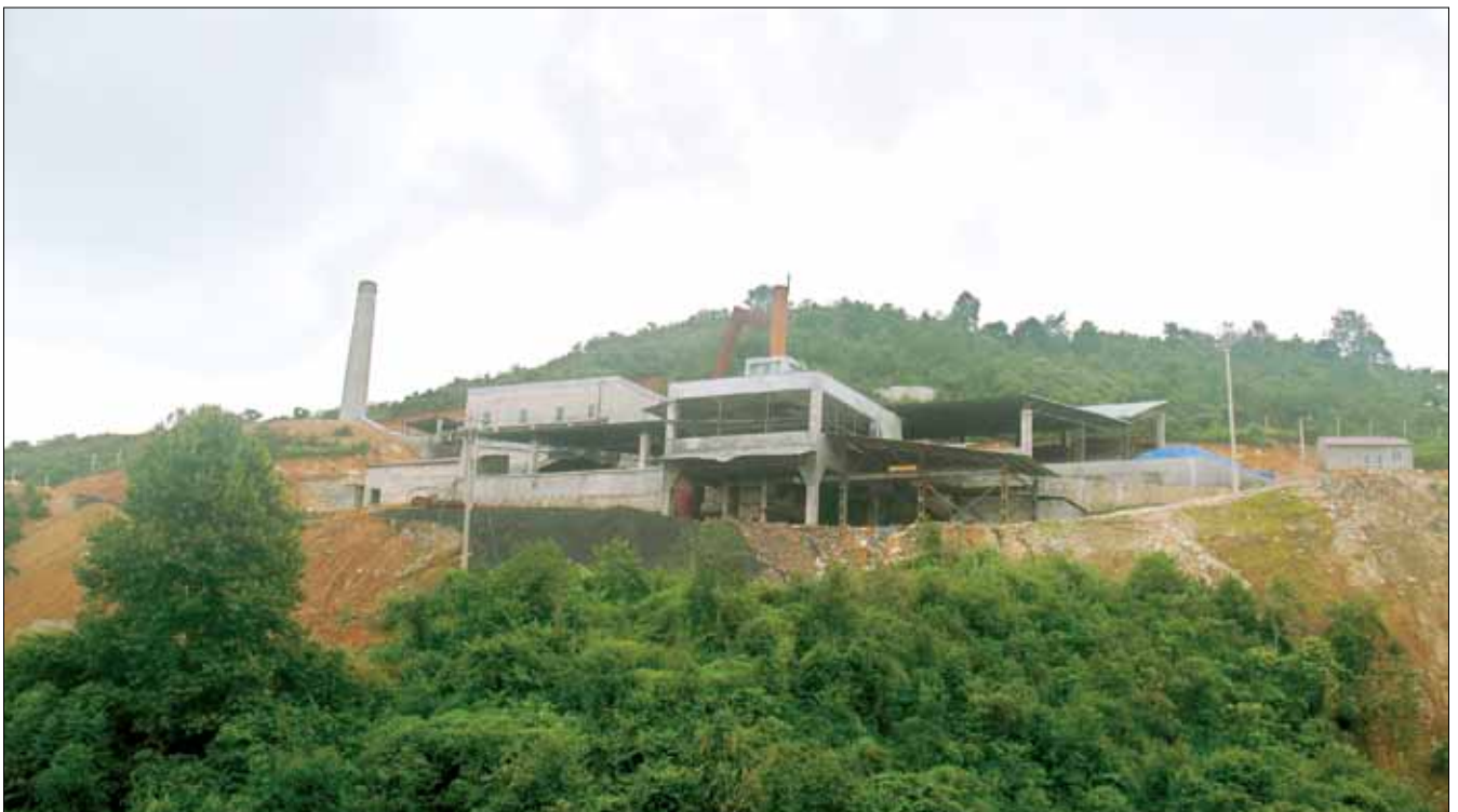
▲ Nhà máy chế biến quặng đa kim của Công ty CP Khoáng sản Na Rì Hamico - Bắc Cạn
