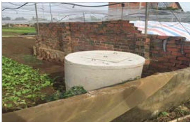
▲ Bể thu gom vỏ bao bì thuốc BVTV
