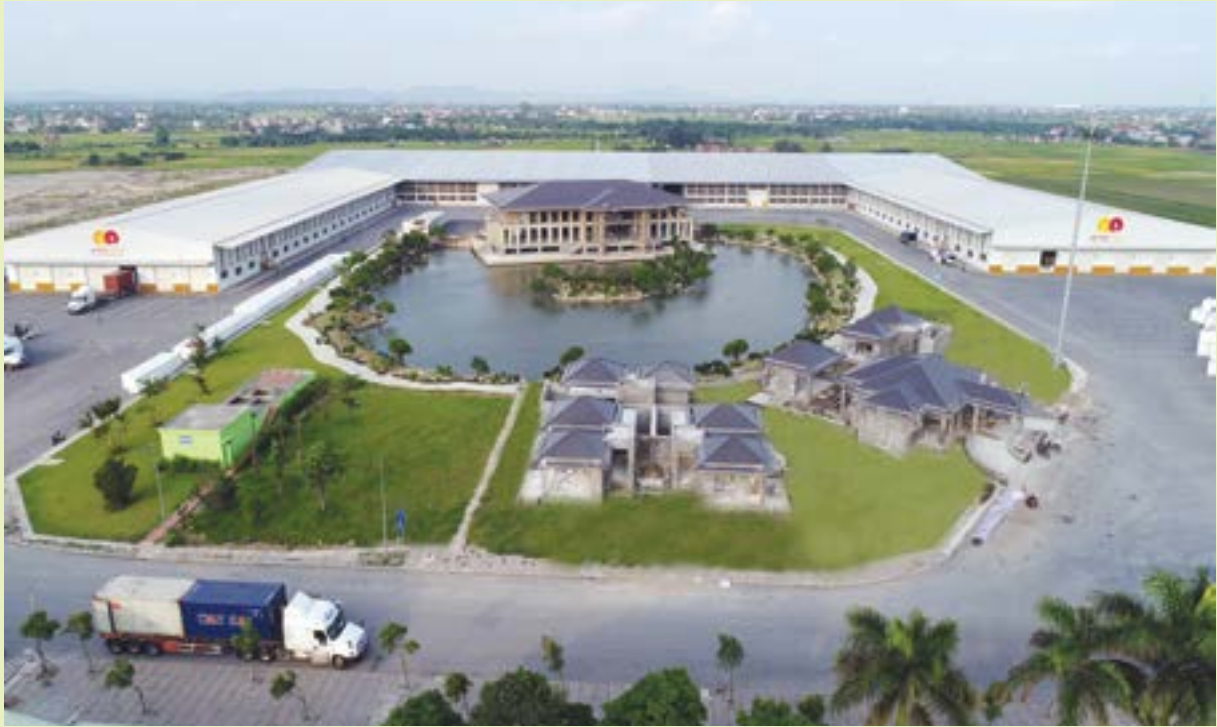
▲ Nhà máy sản xuất số 6
