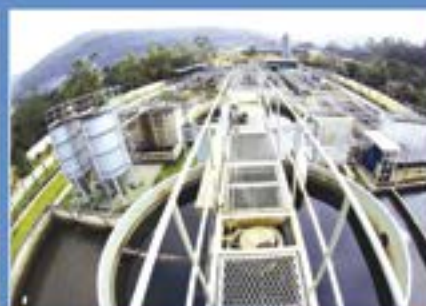
Trạm xử lý nước thải mỏ Vàng Danh - Công ty TNHH MTV Môi trường - TKV
