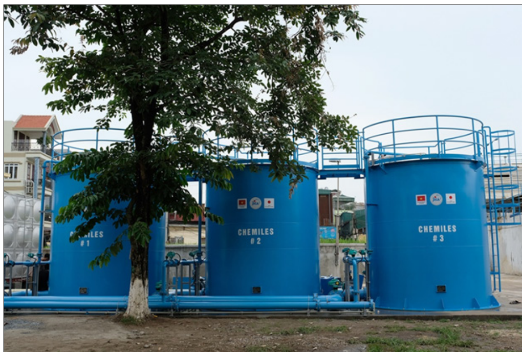
▲ Hệ thống xử lý đồng thời sắt, mangan, amoni trong nước ngầm bằng công nghệ Chemiles, để tài hợp tác nghiên cứu ứng dụng giữa Công ty Nước sạch Hà Nội, Công ty Nagaoka (Nhật Bản) và Bộ môn Cấp thoát nước (Trường Đại học Xây dựng) thực hiện
