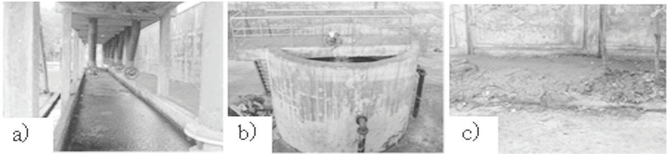
▲ Hình 4. Một số hình ảnh vận hành nhà máy XLNT
